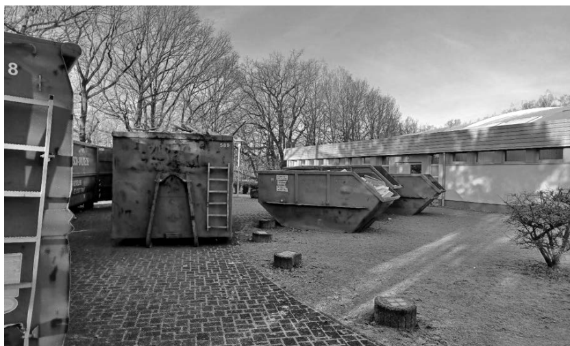
Im Gespräch mit dem Kultusminister ging es auch um das Problem mit der vor nunmehr zwei Jahren geschlossenen Turnhalle. Bereits im Dezember wurde, wie im Bild zu sehen, kontaminiertes Material aus dem Gebäude entfernt.
