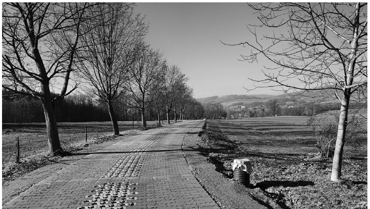
Der Bierweg Mitte Februar. Inzwischen ist das Pflaster eingesandet, die Dränageschächte sind ausgepflastert. Bis Ostern wird fast alles fertig sein.
