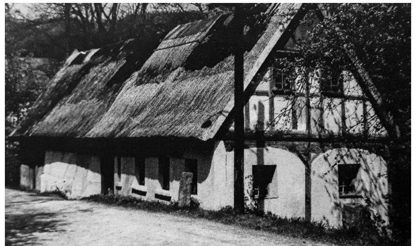
Oberlausitzer Straße 30. Das Haus war einst strohgedeckt und nur mit dem Notwendigsten ausgestattet.
