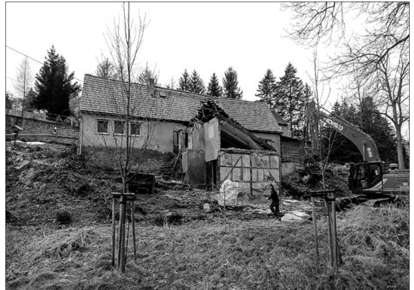
Oberlausitzer Straße 30. Der Bagger hat am Ende wenig Mühe, das marode Haus abzutragen.
