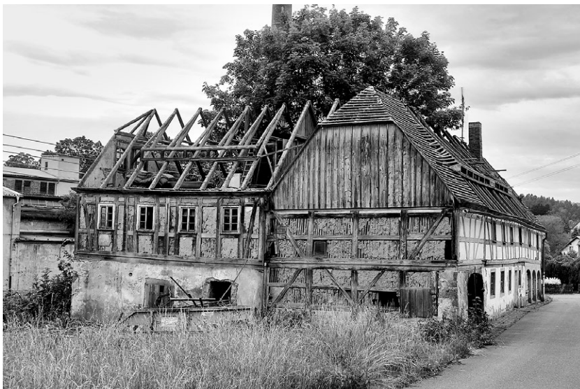
Reichenstraße 1. Der Abbruch des nicht mehr sanierbaren Hauses ist in Angriff genommen worden.
