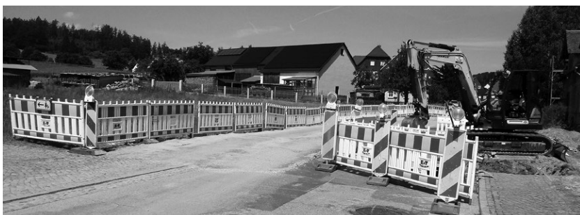
Die Herstellung einer Überleitungsverrohrung in Schönberg gestaltet sich schwierig. Die Überleitung soll bei starken Regenfällen die bestehende Verrohrung entlasten. Mehr dazu in der nächsten CBZ.
