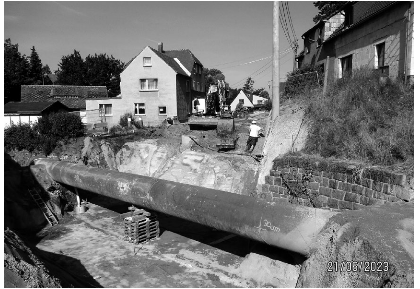
Blick in die Baugrube auf der Hauptstraße im Oberdorf. Die Arbeiten am neuen Fundament sind bereits in vollem Gange. Lesen Sie auch auf Seite 5.
