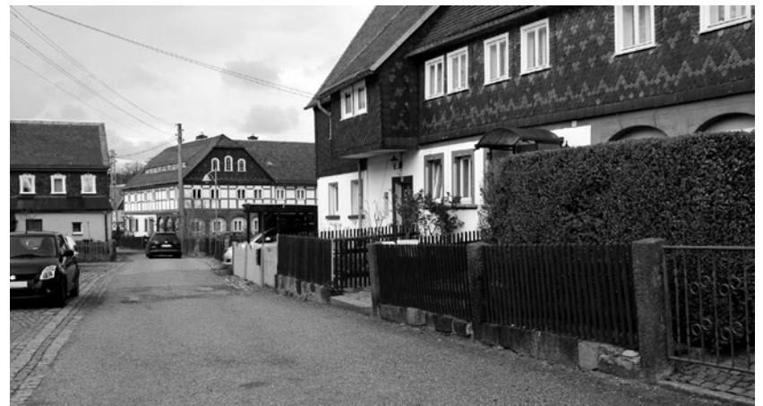
Auf dem Erlenweg sind mehrere Stellen neu zu pflastern. Nach der Flut waren Sie mit Asphalt notrepariert worden.
