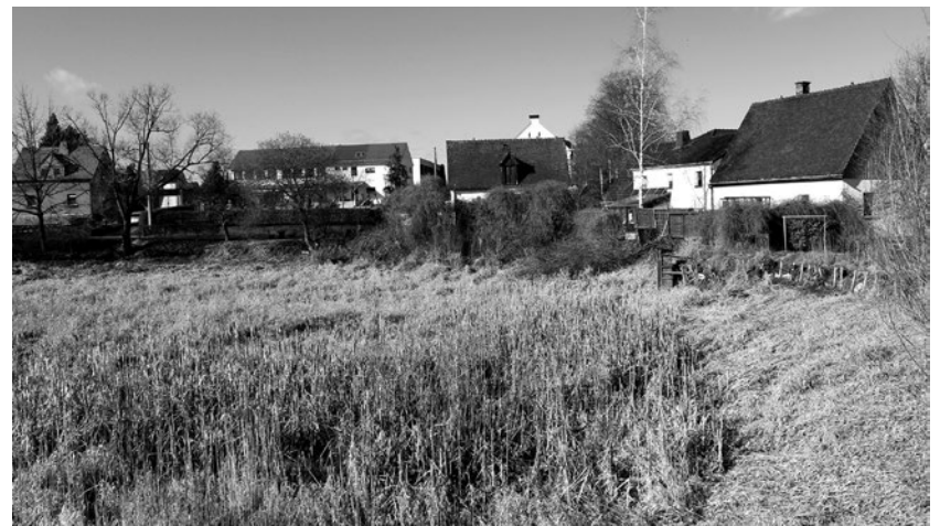
Der Schlosserteich mit seiner sensibelsten Stelle, der Stützmauer mit dem Überlaufbauwerk. Bald ist hier Baustelle.
