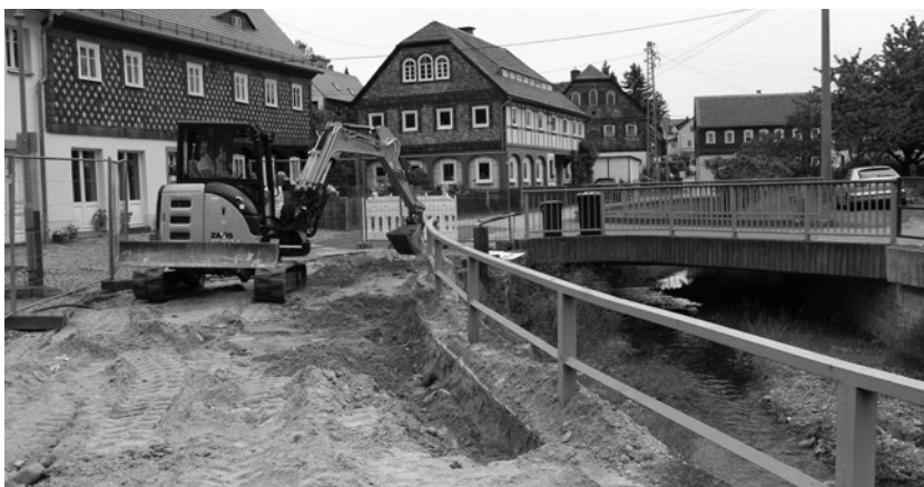
Hier sind noch Vorbereitungsarbeiten im Gange, seit Montag ist mehr Technik im Einsatz.
