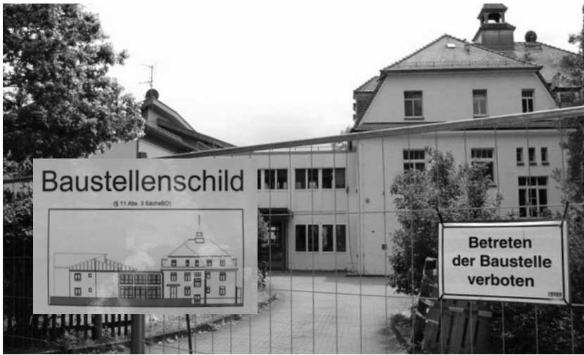
Die Bauarbeiten am ASB-Pflegeheim „Am Czorneboh“ sind vorige Woche mit ersten Maßnahmen gestartet.
