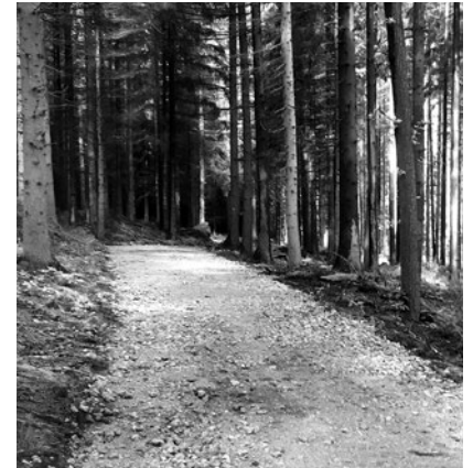
... und nach der Instandsetzung.
