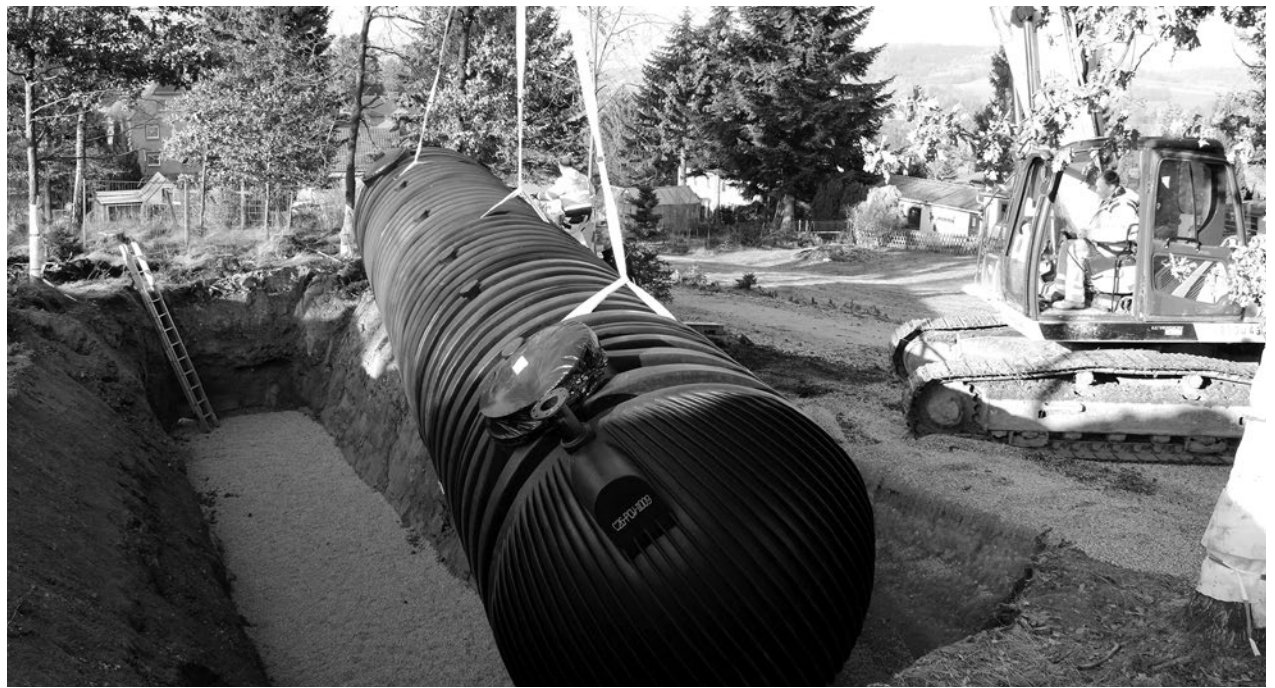
Der Löschwasserbehälter ist 14 m lang, per LKW kam er Anfang Dezember aus der Nähe von Strasbourg in Frankreich.
