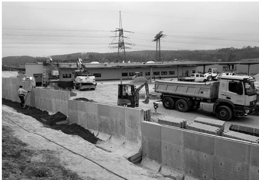
Auf der Baustelle für das neue Postverteilzentrum an der Köblitzer Straße herrscht noch voller Baubetrieb. Das Vorhaben der Deutschen Post soll im Januar abgeschlossen sein.
