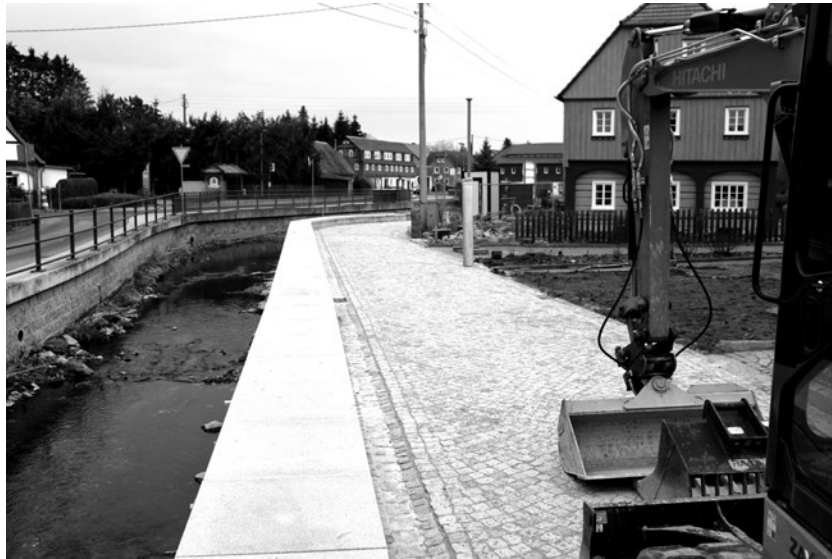
10 Jahre nach dem Hochwasser ist der Erlenweg endlich wiederhergestellt worden.
