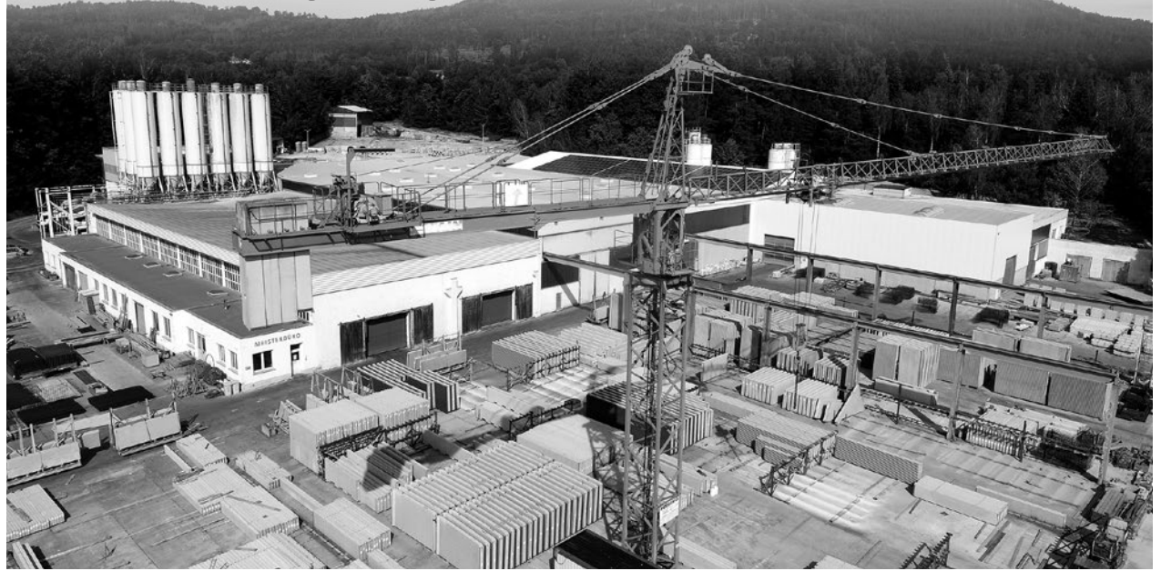
Blick auf das Betonwerk Schuster aus der Vogelperspektive.
