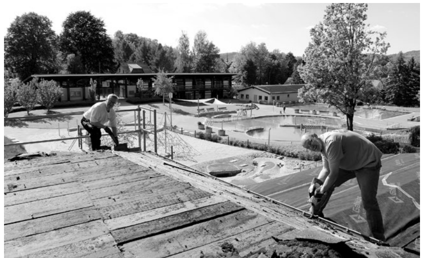
Sören Trillenbergs und Arne Hilbig auf dem Dach des Schwimmerhäuschens. Nach dem Entfernen der alten Dachpappe kamen marode Schahlbretter zutage.
