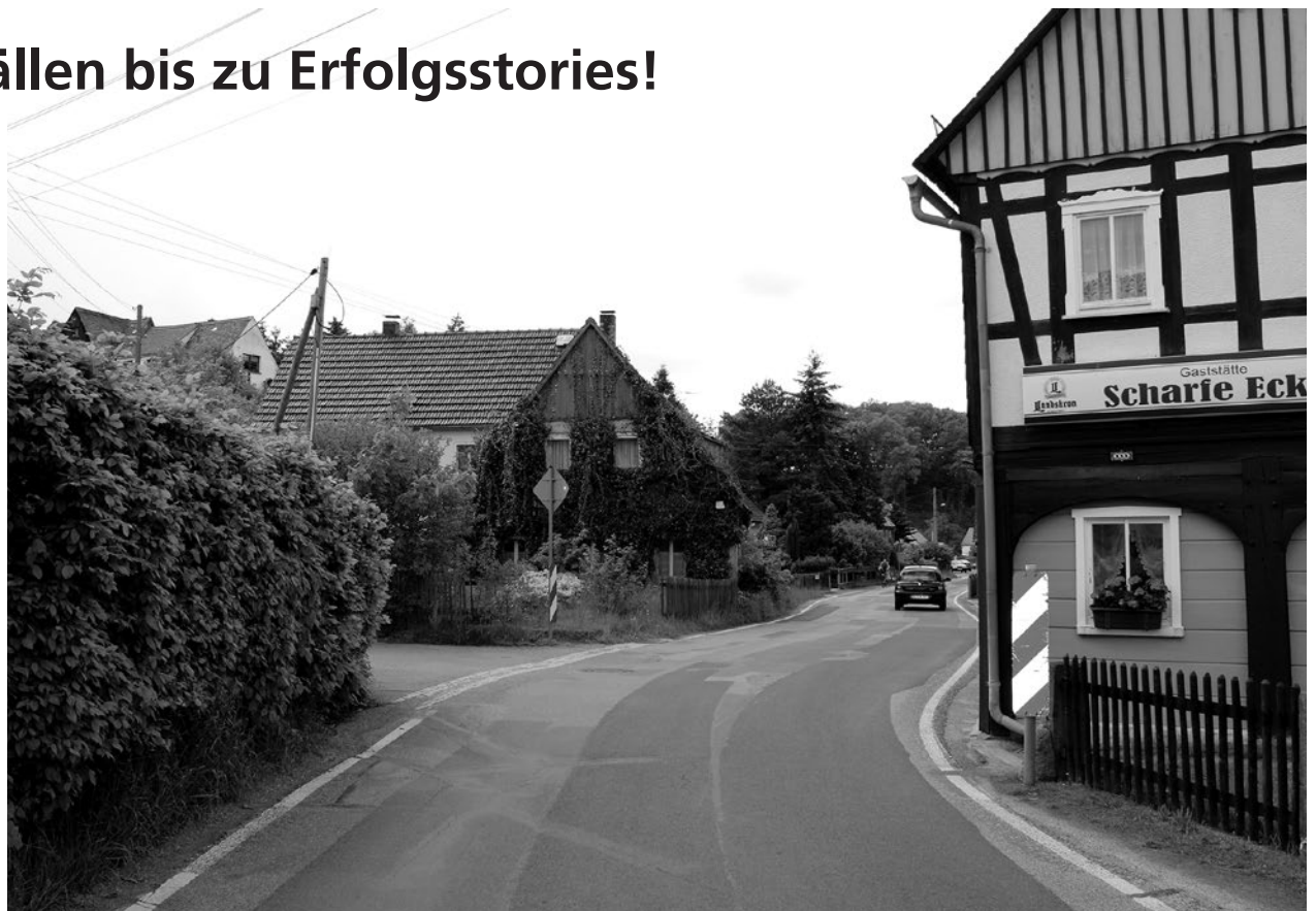
Hauptstraße 172. Nach dem Ableben der ehemaligen Eigentümer (Mieth) hatte die Gemeinde das Anwesen erworben, um Raum zu gewinnen für bauliche Maßnahmen im Zuge des künftigen Straßenausbaus auf Höhe „Scharfe Ecke“.
