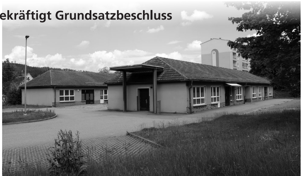
Die Vorbereitungen auf die Nutzbarmachung dieser Immobilie ASS 31a laufen. Nachdem die Deutsche Post im Herbst hier ausgezogen sein wird, sollen einmal Kinder und Senioren hier Einzug halten.
