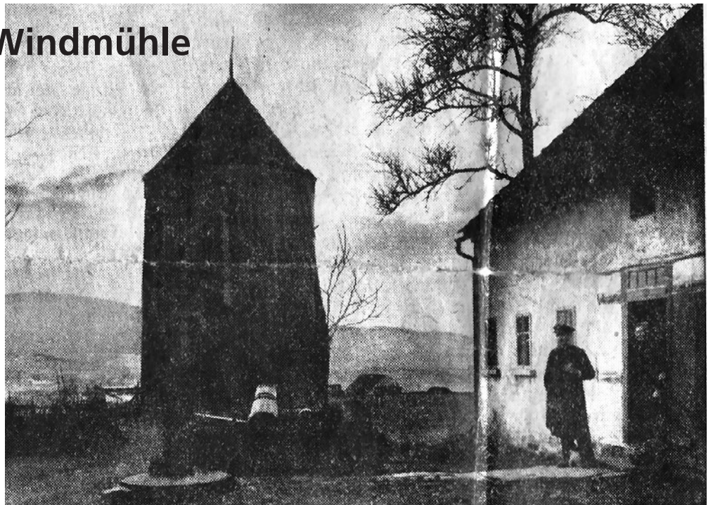
Von der Windmühle gibt es wenige Bilder. Dieses stammt aus der Zeit um 1920. Schon da war sie außen nur notbedürftig verbrettert.
