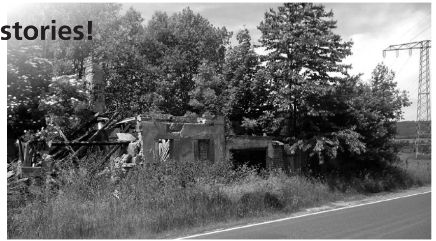
Wildwuchs überdeckt inzwischen weite Teile der sogenannten Brandruine an der Neudorfstraße.
