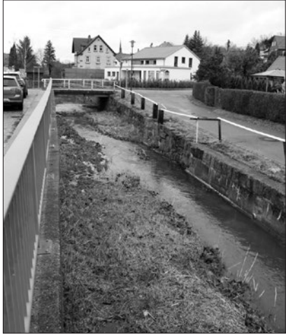
Diese Stützmauer am Erlenweg wird 2022 grundhaft saniert.
