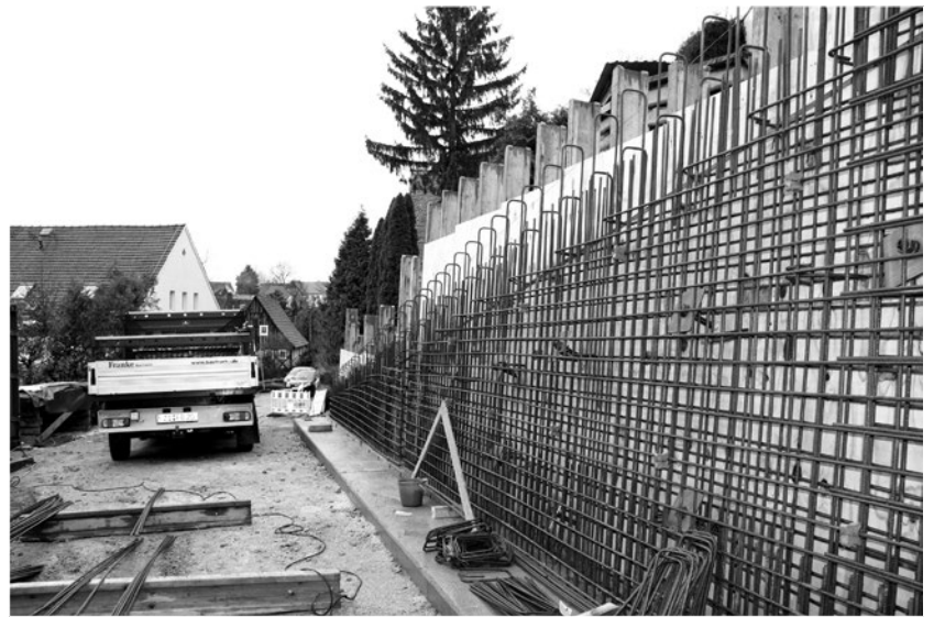
Für die Stützmauer im Mitteldorf sind aktuell Arbeiten an der Bewehrung im Gange.
