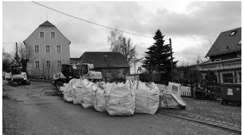
Das Granitpflaster liegt bereit, noch vor Weihnachten soll es am Kirchweg eingebaut sein.
