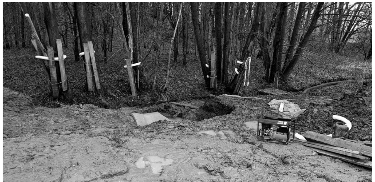
Blick auf die Baustelle in der Wolfsschlucht, wo ein Damm entsteht.
