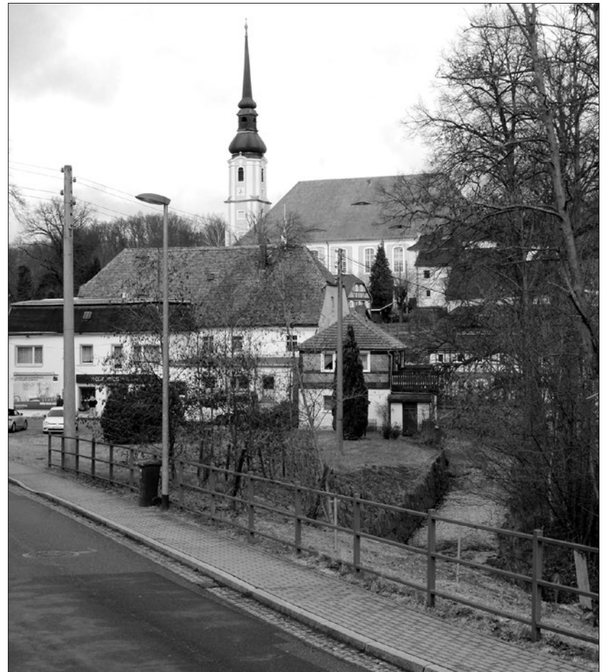
Die Cunewalder Kirche ist das weithin sichtbare Wahrzeichen im Tal. In unserer Dezemberausgabe hatten wir gefragt, wieviel Quadratmeter Fläche wohl das zu sanierende Kirchendach hat. Der Ausschreibung für die anstehenden Dachdeckerarbeiten zufolge sind es 1.655 m 2 .
