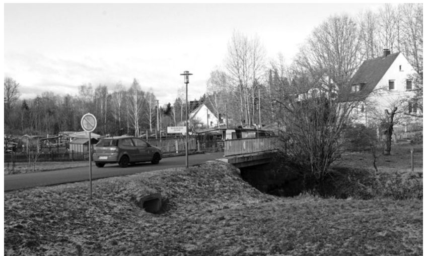
Die Brücke zum Nordhang wird im Jahr 2022 auf jeden Fall saniert.
