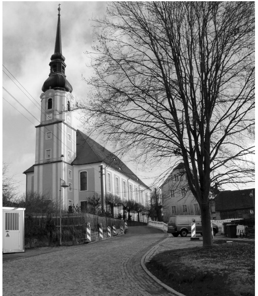
Die Arbeiten auf dem Kirchweg werden wohl noch gut 6 Wochen in Anspruch nehmen.
