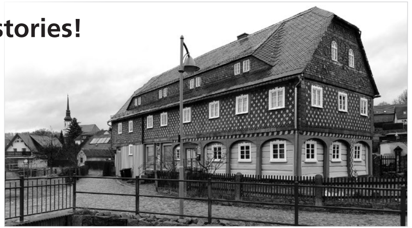
Ortsbildprägend und mit guten Aussichten auf eine erfolgreiche Sanierung: Hauptstraße 47.
