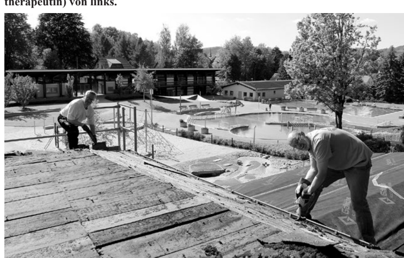
Gemeinschaftswerk fertig: Das alte Schwimmerhäuschen im Bad wurde vom Förderverein komplett erneuert.
