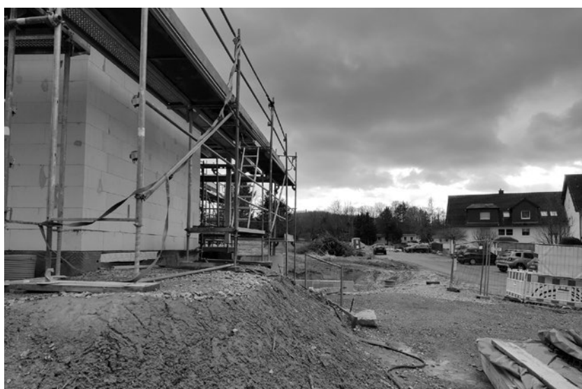
Blick in die Friedensau. Links der bereits fertige Rohbau des ersten Eigenheimes. Weitere Neubauten sind vorbereitet.
