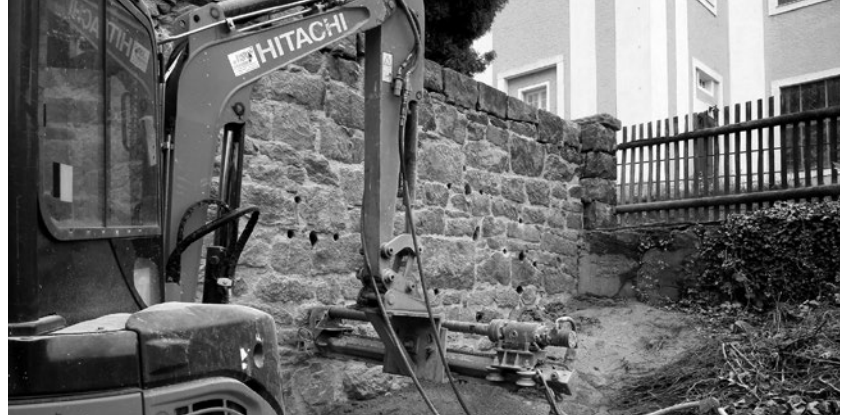
Stützmauer erneuert. Das höher liegende Denkmal an der Kirche wurde gesichert.
