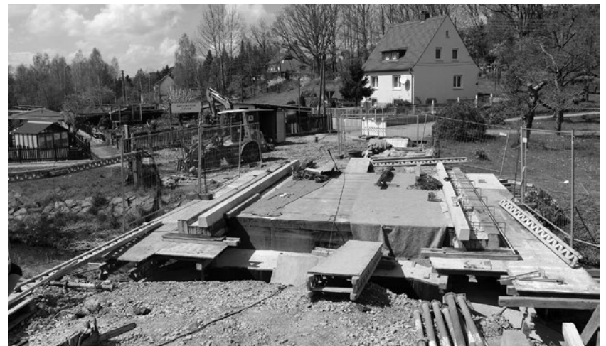
An der Brücke zum Nordhang laufen die aufwendigen Arbeiten zur Sanierung ohne Zeitverzug.
