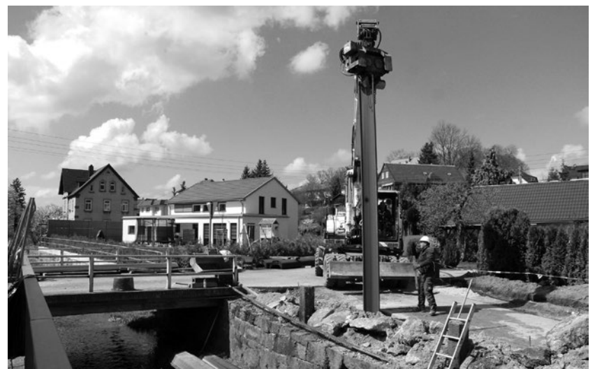
Schweres Gerät war notwendig, um die Stahlplatten zur Sicherung der Baustelle am Erlenweg einzuschlagen.
