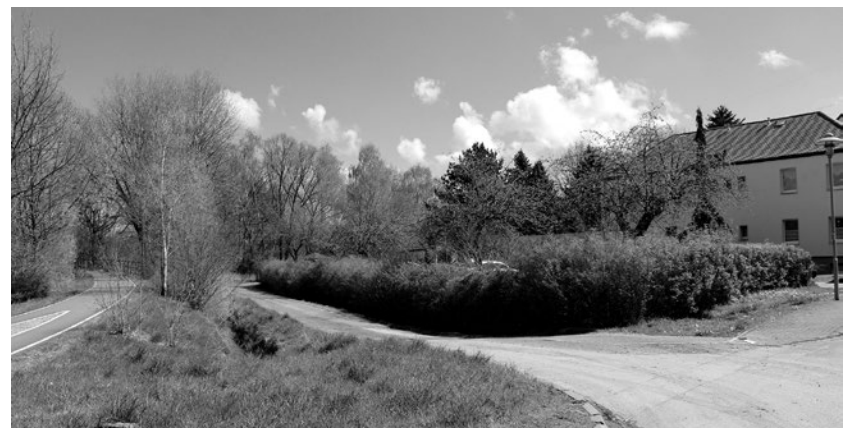
Hier beginnt in Kürze das Bauvorhaben Bierweg, der bis hinauf zur Gemeindegrenze auf dem Bielebohkamm ausgebaut wird.
