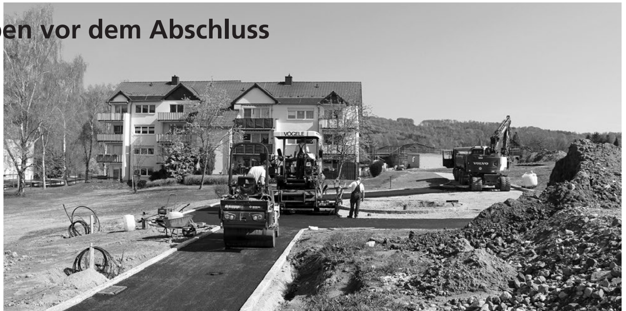
Ende April erhielten die neue Erschließungsstraße und der Verbindungsweg Richtung Kita in der Friedensau die Asphaltdecke.
