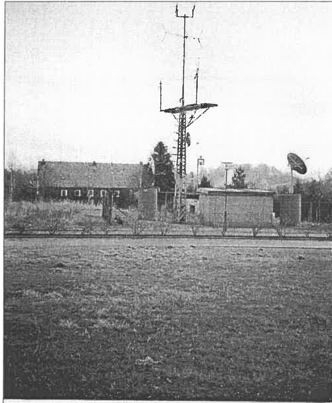
ABB. 8: ANTENNENSTANDORT AM SIEDLUNGSWEG
