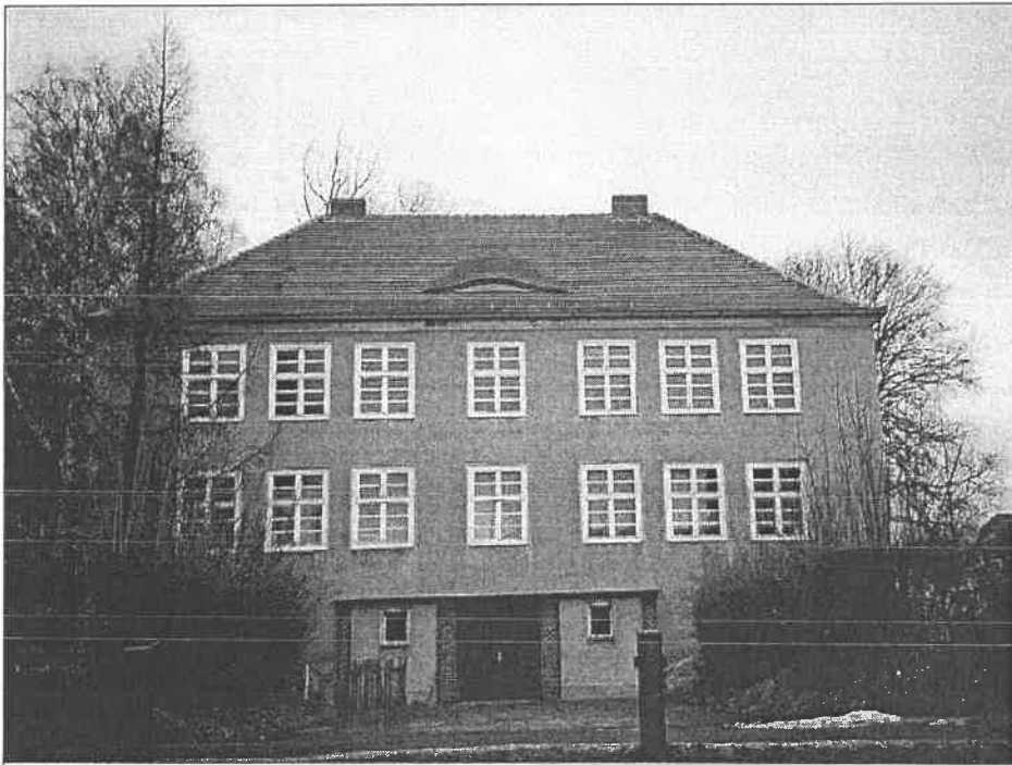
ABB. 4: DENKMAL EHEMALIGER KINDERGARTEN
