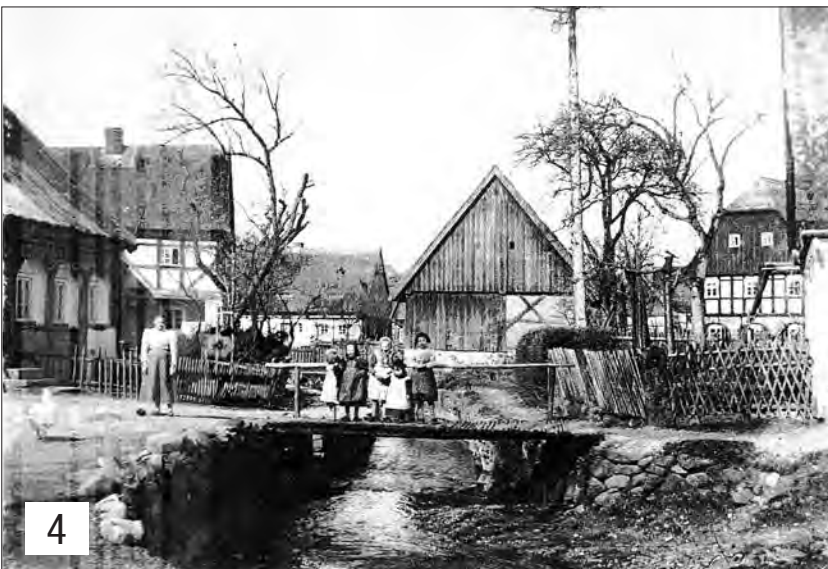
Dieses sehr alte Foto zeigt die örtlichen Verhältnisse am Cunewalder Wasser sehr deutlich. Vieles ist auf das Einfachste hergestellt. Die Holzbrücke gibt's längst nicht mehr, auch die letzte Nachfolgerin wurde vor ein paar Jahren rückgebaut. Ja – wo sin'ner denn?
